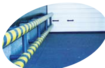
Plancher de garages
