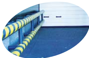
Plancher de garages
